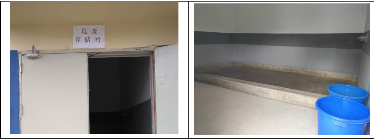
图 10.3-1 金阳车辆段危险废物暂存间
